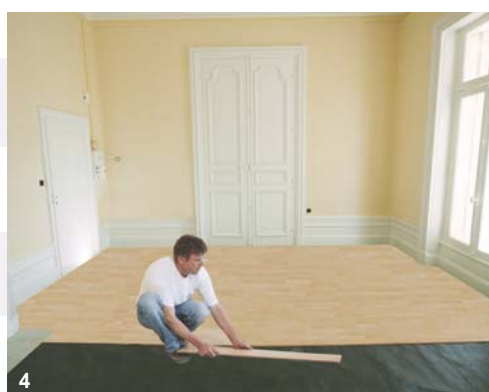
1 - Mise en œuvre des dalles 2 - Pose des tubes 3 - Pose de la sous-couche 4 - Pose du parquet
