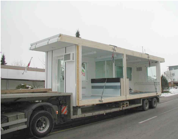
Un module d'Erne Holzbau en route pour son montage Photo : Erne Holzbau
