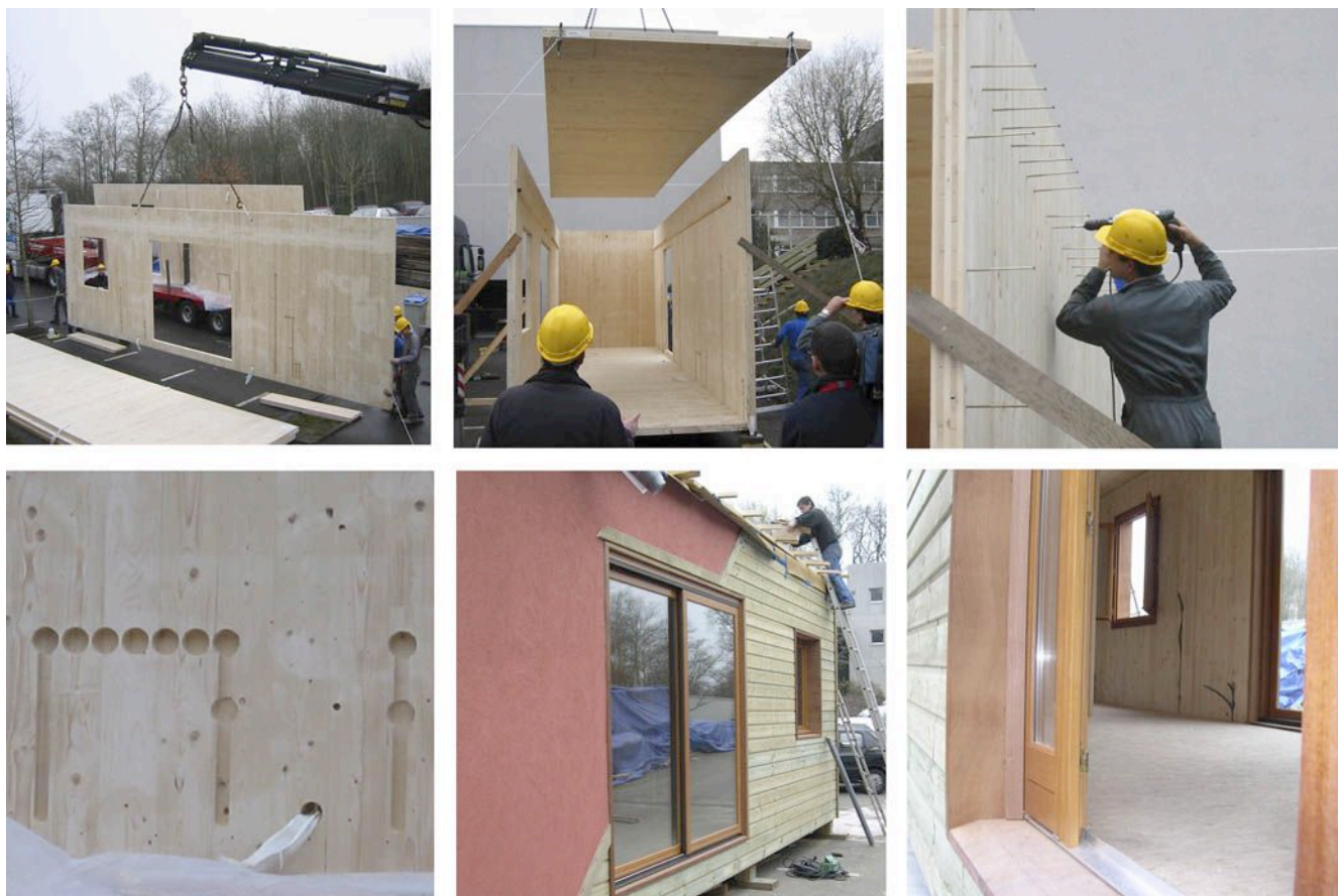
Le module conçu et construit par un groupe d'étudiants de l'ESB, en panneaux de bois massif contrecollé-croisé Leno - images DR
