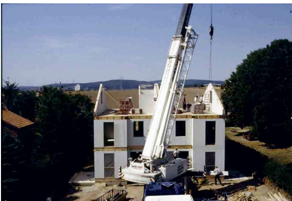
Montage d'une maison double en 8 modules en fin de la 1 ère journée. photo : Otto Baukmeier Fertigbau
