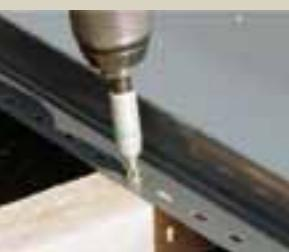
Utiliser les trous prépoinçonnés pour fixer les éléments sur les supports au moyen de vis bois tous les 40 cm.
