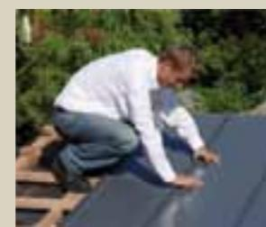
Superposer les panneaux suivants au niveau du clip et presser jusqu'à emboîtement.
