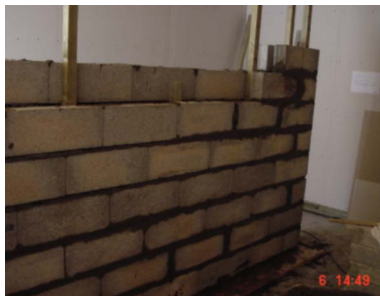
Photo 1 : La paroi interne à forte inertie pendant la phase de construction
