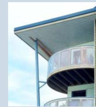
accentués par l'utilisation de matériaux distincts. Le fond des parois (particulièrement celles exposées à l'ouest) est revêtu d'un bardage en acier blanc, les garde-corps des balcons sont habillés de panneaux bakélisés rouges alors que les masses cintrées ou signalant un fort relief sont bardées de clins horizontaux en pin. Pour protéger les loggias et les façades bois, de larges auvents courent autour de l'im-
