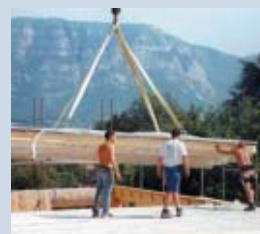
● Mise en place d'une dalle composite bois-béton préfabriquée. Des échafaudages périmétriques assurent la sécurité des personnes
