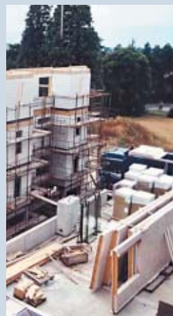
▲ Entreposés sur la dalle, les panneaux de façade préfabriqués ont été livrés finis avec leurs parements intérieurs et extérieurs.
