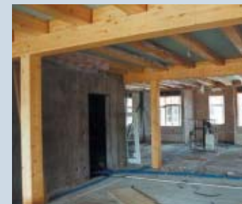
● Intérieur d'un appartement : les structures bois restent apparentes.
