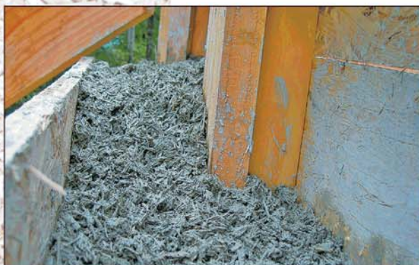
Vue du remplissage d'un mur banché
