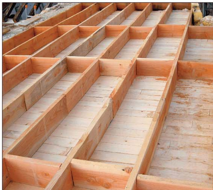
Vue d'un coffrage avant remplissage
