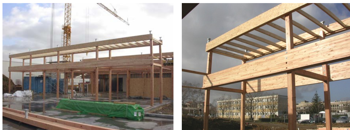
Illustration 10: Structure primaire de l'ossature bois
