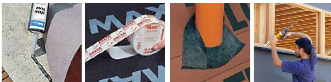
Illustration 37: Pare-pluie - Accessoires de collage et d'étanchéité des liaisons du pare-pluie
