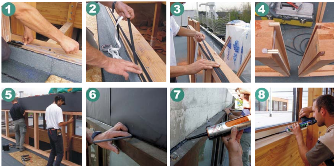
Illustration 31: Processus de mise en œuvre des menuiseries
