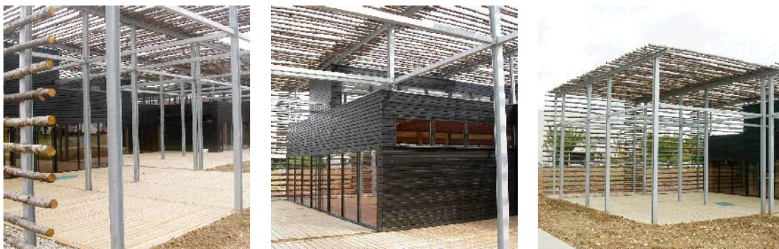
Illustration 46: Ombrière sur toiture et terrasse du restaurant
