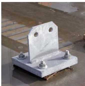
Illustration 11: Pied de poteau en acier galvanisé
