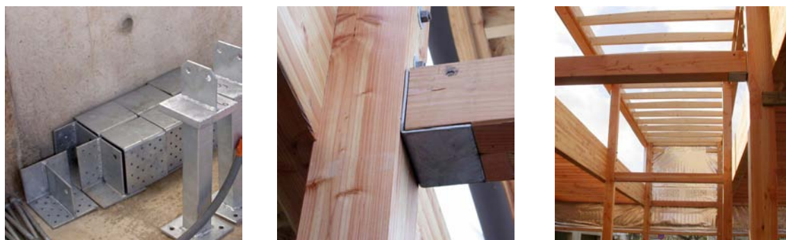
Illustration 14: Chantier de la structure primaire
