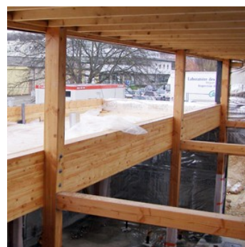
Illustration 12: Assemblage des poutres primaires sur les poteaux
