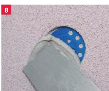
Comblez les orifices des chevilles avec le mastic de remplissage MULTIPOR.
