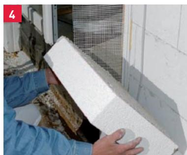
La couche de mortier-colle doit faire environ 10 mm d'épaisseur. Cela permettra de gommer les inégalités du support sur une profondeur allant jusqu'à 5 mm.
