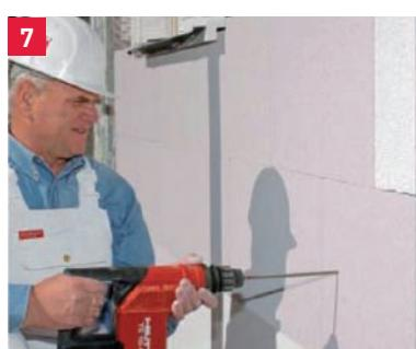
Consolidez la fixation des panneaux avec des chevilles à marteiller appropriées.
