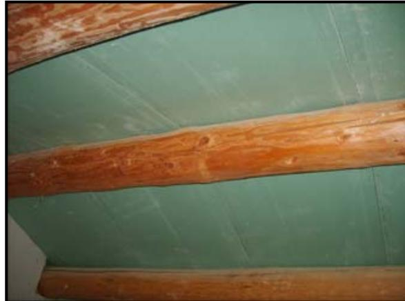
Il existe une large gamme de panneaux de toits isolants répondant aux exigences de la **RT 2005**, produit appréciable pour sa maniabilité et sa facilité de pose, gain de temps avec son isolation et sa sous en face en plaque de plâtre hydrofuge.
