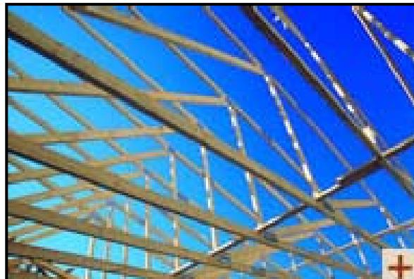
L'ensemble est généralement voligée avant de recevoir la couverture en tuile mécanique. L'isolation se fait dans les combles avec de la laine de roche ou de verre, projetée ou en rouleau. Pas de récupération possible des combles, plafonds uniquement horizontal, peu esthétique.
