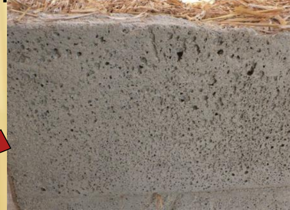
4-Le mortier allégé, coulé pour la solidité et l'inertie
