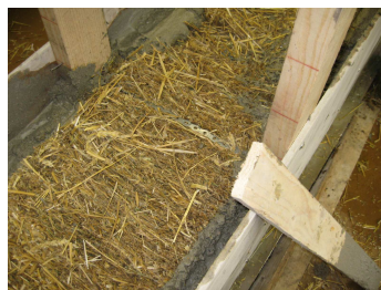
Figure 2.3 : Mortier coulé contre les ballots de paille
