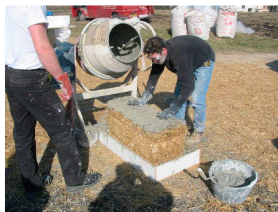
Figure 2.8 : Trempage des bottes de paille
