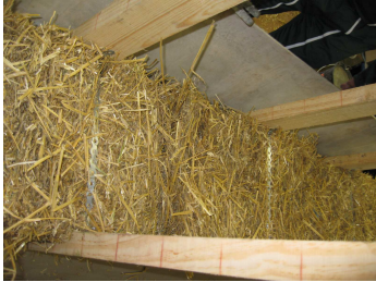
Figure 2.1 : Structure bois avec remplissage paille et feuilards
