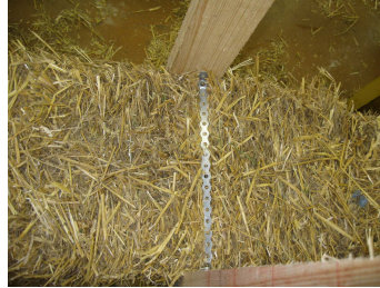
Figure 2.2 : Feuille métallique entre deux montants
