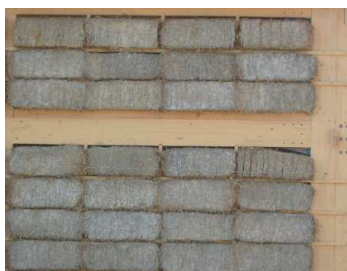
Figure 2.9 : Mur rempli de ballots de paille trempés
