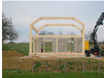
Figure 2.7 : Portique tridimensionnelle de la maison de Montholier
