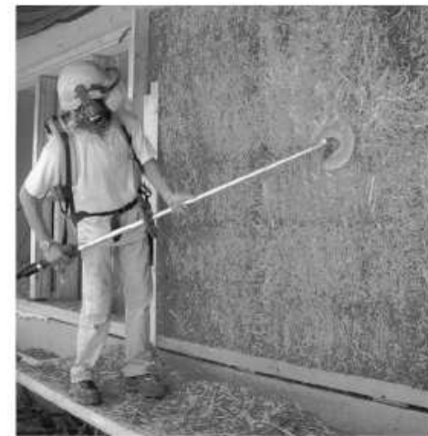
Fig. 3.12. Dressage de parois en paille avant réalisation des enduits
