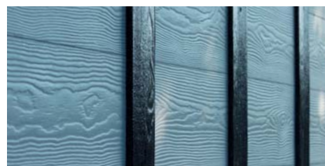
Exemple de pose à bords jointifs (avec colombages verticaux)
