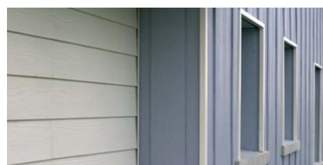
Exemple de combinaison de pose horizontale et de pose verticale
