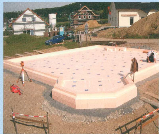
chantier DÖRFEL, Allemagne
