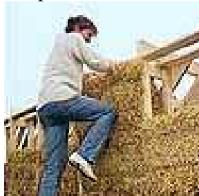
Figure 11 : Maison montée en botte de paille.
