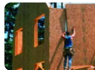
Étape 4 : L'installation des panneaux Insulspan se poursuit au deuxième plancher.
