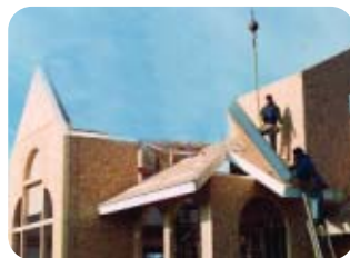
Étape 6 : Les panneaux de toit Insulspan sont montés au moyen d'une grue.
