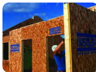
Étape 3 : Les panneaux Insulspan sont installés; les ouvertures brutes sont prédécoupées.
