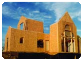
Étape 5 : La plupart des panneaux muraux Insulspan sont installés.
