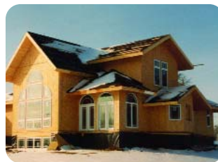
Étape 7 : L'enveloppe du bâtiment, y compris le toit, les fenêtres et les portes, est entièrement installée.
