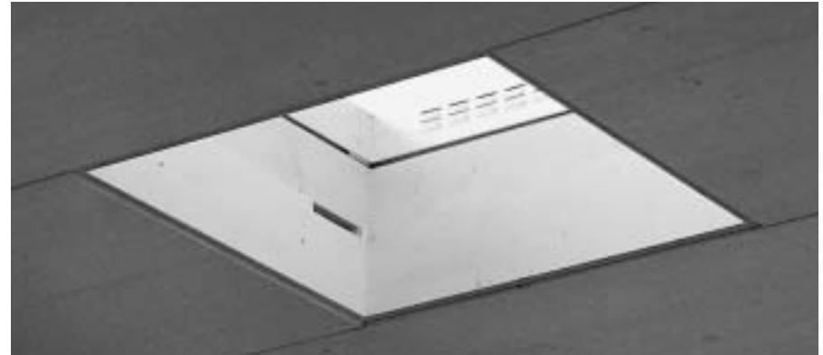
Une fois les chevêtres calculés, il faut les installer dans les règles de l'art. Les supports en bois collé-lamellé et les supports métalliques UPE se prêtent également aux grandes percées comme par exemple celles nécessaires pour les escaliers.
