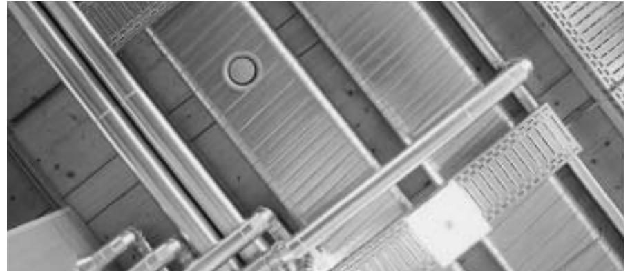
Grâce à la composition correspondante de la construction de plancher LIGNATUR, il est possible de prévoir des canaux techniques déjà intégrés en atelier par exemple pour l'installation d'un éclairage zénithal ou de sprinklers dont le tracé est régulier et répétitif. Ceux-ci peuvent être recouverts d'une lame démontable qui sera montée de manière à ce que le gonflement et le retrait des éléments LIGNATUR ne soient pas gênés.
