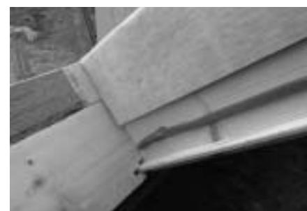
Isolation de joints, joint de caoutchouc butyle (presser de chaque côté)
