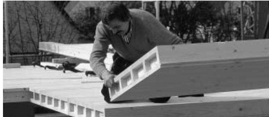
Dans la mesure du possible, les éléments LIGNATUR sont, après accord avec l'entreprise, empilés et livrés dans l'ordre de priorité du montage. Les éléments sont livrés en paquets d'environ 1 x 1 m et pèsent jusqu'à environ 2 t.
