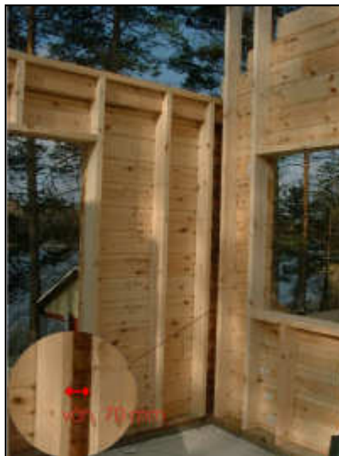
Aux coins extérieurs, ouverture (70 mm) pour soufflage de l'isolant
