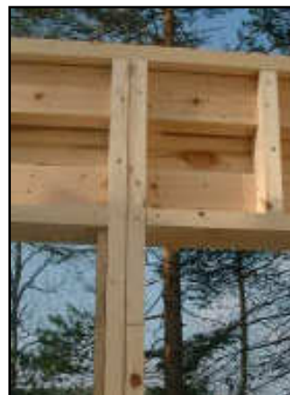
Joint calfeutré entre poteaux
