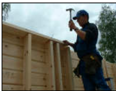
Fixation du cadre haut (plafond charpente à ferme)
