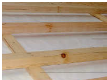
Feutre sous toiture Liteau Liteau de ventilation
