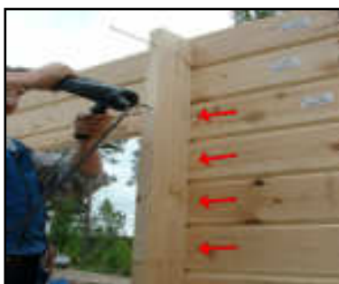
Fixer chaque madrier aux coins et à côté des ouvertures
