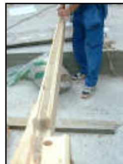
L'isolation des madriers d'en haut peut être effectuée par terre avant de les monter
