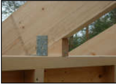
Point d'intersection entre le chevron et le mur extérieur
