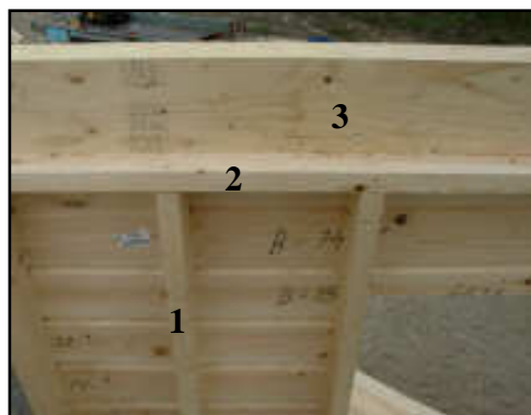
Structure de l'ossature en vue d'un plafond charpente à fermettes
