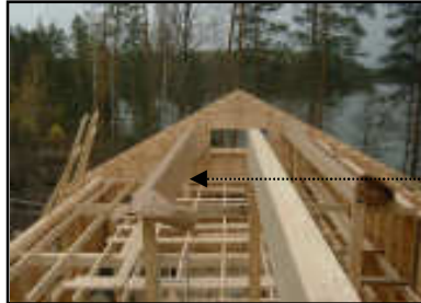
Les pannes de support pour chevrons, avec le papier posé
