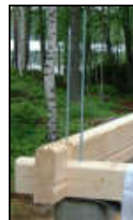
Vérifier qu'il est possible d'installer et de serrer les tiges filetées et tubes de support
