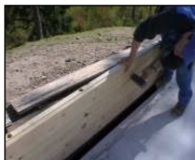
Dans le but de bien positionner les madriers, il est possible de taper légèrement leur surface intérieure qui restera invisible.
