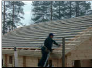
Liteaunage pour un toit couvert de tuiles
