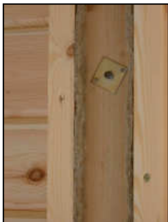
Joint calfeutré entre contre-pièces et poteaux
