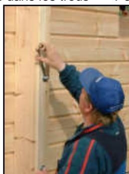
Tiges filetées dans les trous
