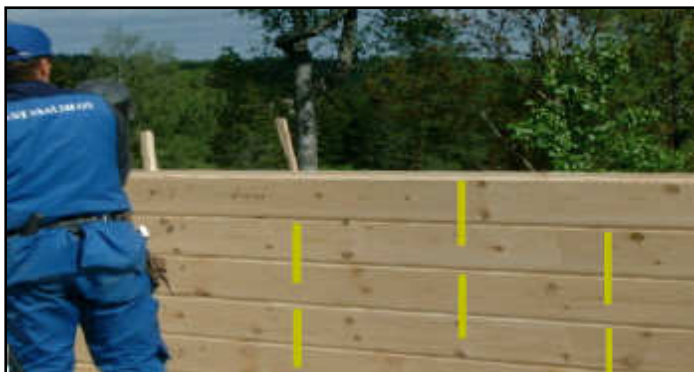
Chevilles en alternance sur un mur long
