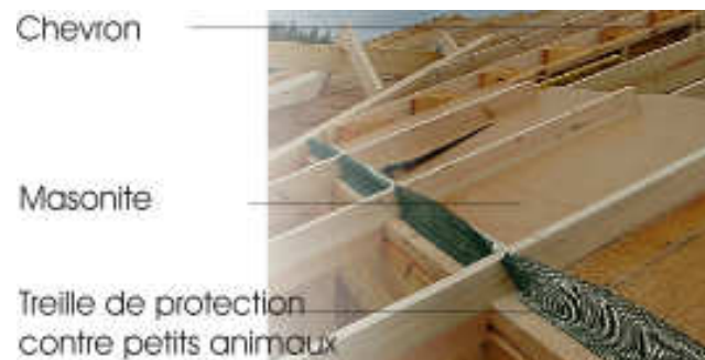
Les pannes de support pour chevrons, avec le papier posé
