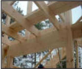
Poutre de support du plancher
