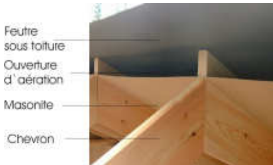
Point d'intersection entre le chevron et le mur extérieur
