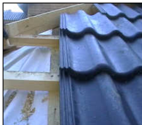
Feutre sous toiture Liteau Liteau de ventilation
