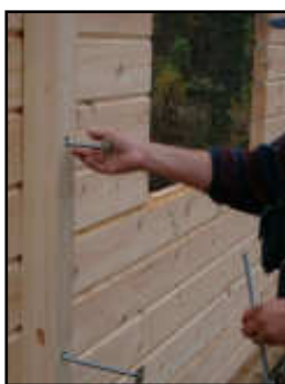
Tiges filetées dans les trous
