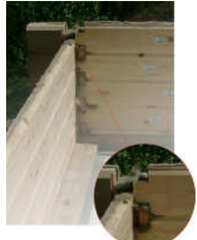
Calfeutrage des entailles d'assemblage
