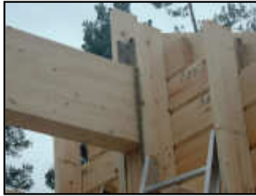
Chevron du toit prenant l'appui du mur extérieur
