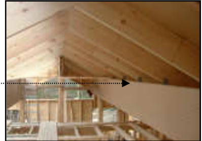
Les pannes de support pour chevrons, avec le papier posé
