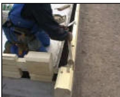
Installation de l'isolant dans les coins (page suivante)
