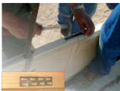
Une entretoise charpente facilite la pose d'un madrier sur une rallonge
