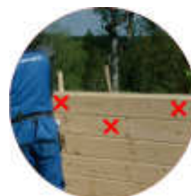
Pour assurer l'écartement entre chevilles, marquer leurs emplacements sur la surface intérieure des madriers
