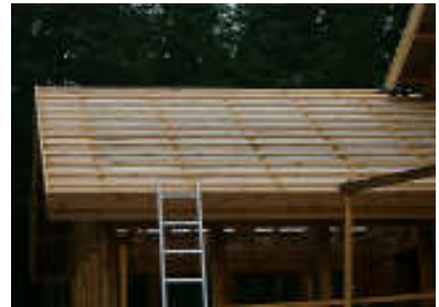
Liteaunage pour un toit couvert de tuiles
