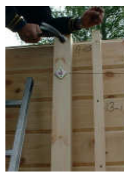
Pose de la contre-plaque filetée
