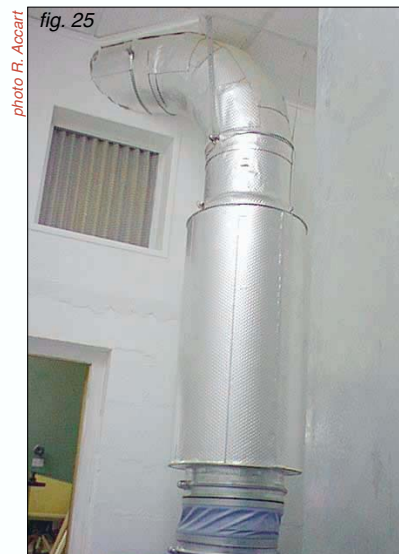
Silencieux adapté sur une gaine de ventilation.
