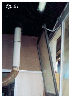
La prise d'air est réalisée tout simplement en ouvrant une fenêtre directement dans la cabine.
