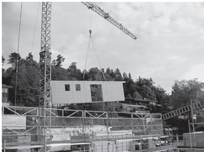
Montage d'éléments ossature bois préfabriqués
