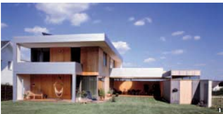
1. CETTE MAISON DE 290 M 2 a été achevée en Autriche en 2006. Elle consommera 15 kW/m 2 .an pour le chauffage avec des déperditions de 12,30 W/m 2 .
