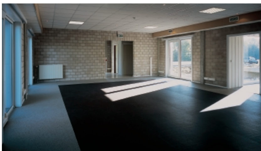
Vue de la grande salle du rez-de-chaussée, destinée aux réunions et aux conférences : la structure portante est en béton recyclé, les murs sont érigés à l'aide de blocs à base de débris de démolition concassés et de ciment blanc, le revêtement de sol comporte une couche inférieure en caoutchouc recyclé; quant au plafond, il a été réalisé au moyen de panneaux à base de laine de roche recyclée.
