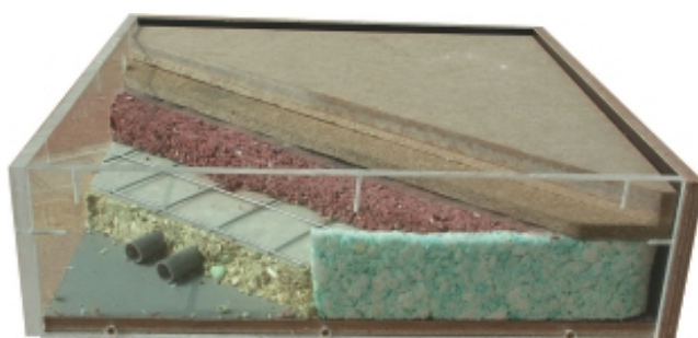
Maquette du sol d'un local de l'étage : on aperçoit la sous-chape en déchets de polyuréthane, la chape en déchets de polyuréthane et de ciment ainsi que le revêtement constitué de deux panneaux de dureté différente, à base de déchets de bois.
