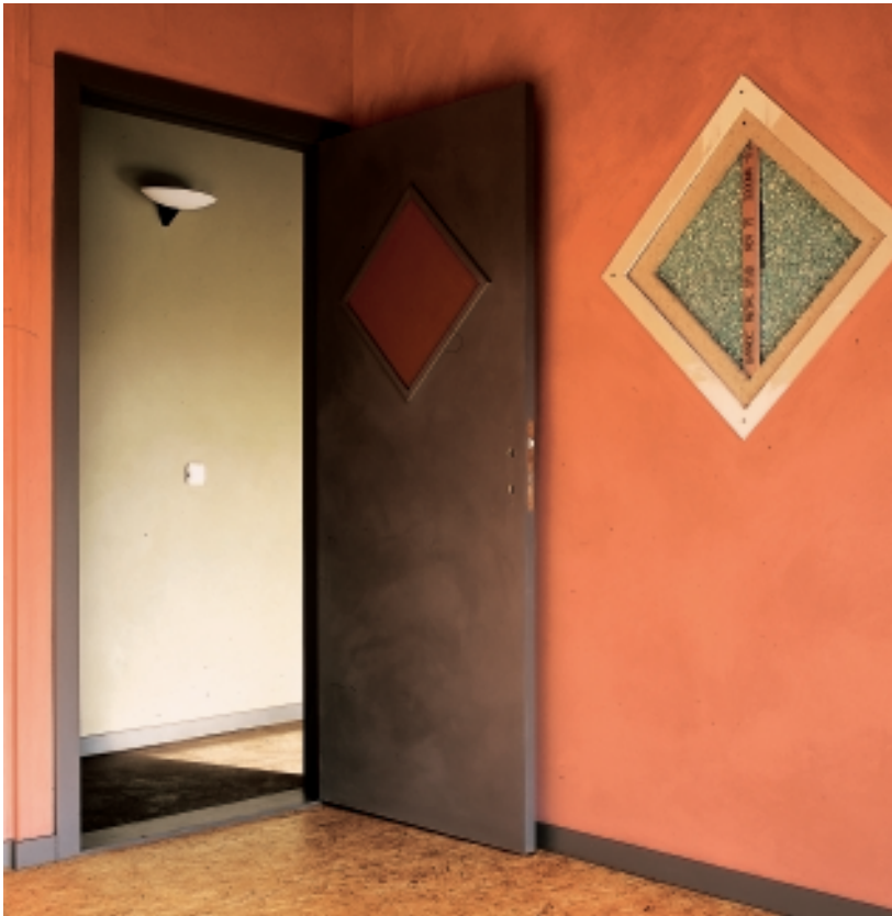
Vue écartée dans une cloison d'une pièce de l'étage, révélant l'isolation en polyéthylène recyclé, un panneau à base de cellulose recyclée et de paille recouvert d'une plaque en sulfogypse peinte. Le sol est en panneaux de déchets de bois.
