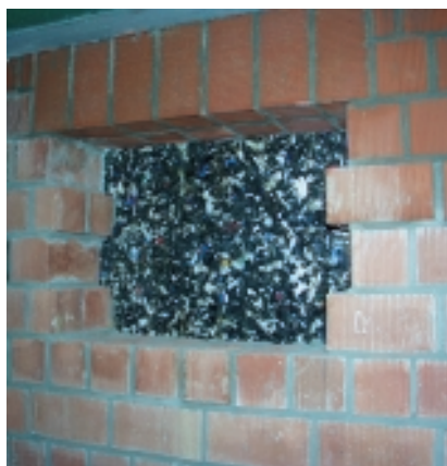
Vue éclatée dans un mur de cave, montrant le drainage réalisé avec des déchets de polyéthylène déchiquetés placés sur un géotextile; mur en blocs de terre cuite contenant des boues de sciage de pierres calcaires et de la sciure de bois.
