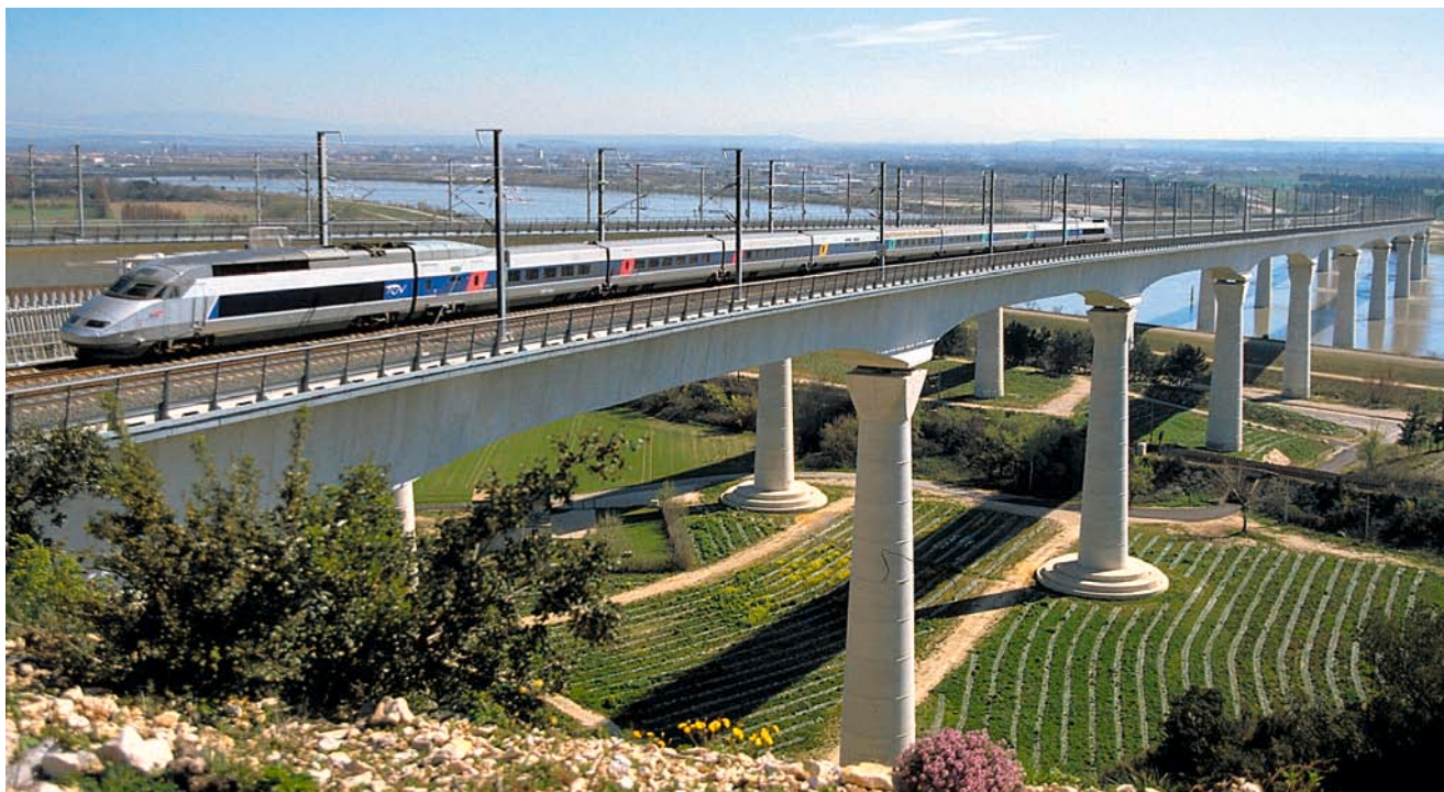
Le TGV méditerranéen franchissant le viaduc d'Avignon (Vaucluse). Sur le parcours de cette ligne, dans les secteurs les plus ventés, notamment sur les viaducs, des écrans brise-vent protègent les trains du mistral. Lors d'épisodes extrêmement violents, avec des rafales à 10 mètres au-dessus du sol dépassant les 130 km/h, le mistral est encore plus fort sur les parties hautes de la ligne (viaducs, remblais). Par mesure de sécurité, les TGV empruntent alors l'ancienne ligne ferroviaire, plus protégée en vallée, et roulent plus lentement. (Photo SNCF-CAV, Jean-Jacques D'Angelo)
