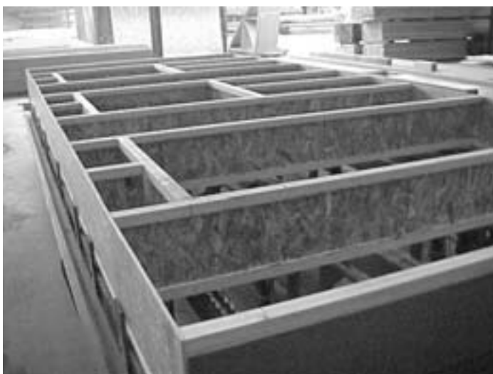
Figuur 6: Passiefhuiswand met raamopeningen en deuropening-
