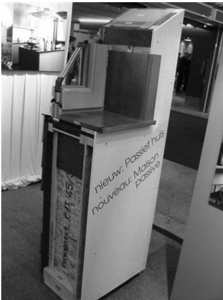
Figuur 4: Eén van de maquettes met een passiefhuiswandopbouw
