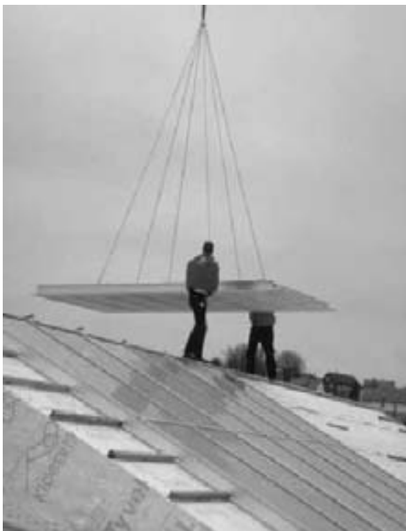
Figuur 53: Geprefabriceerde dakelementen
