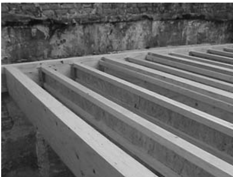
Figuur 30: Kerto S randbalk en Kerto S en FJI's als vloerliggers
