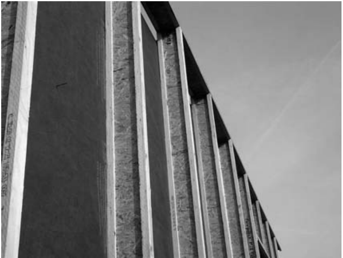
Figuur 28: Toepassing van FJI's bij een wandopbouw
