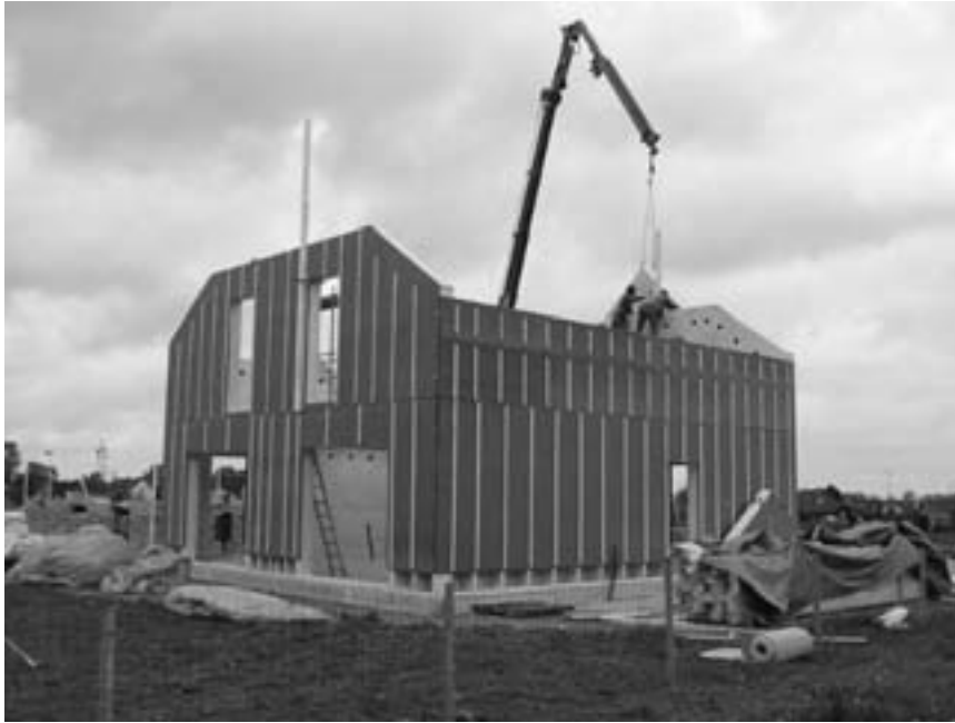
Figuur 31: Toepassing Celit bij de bouw van een passiefhuis
