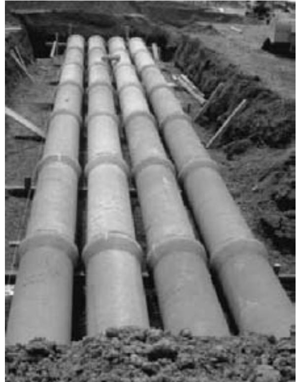
Figuur 55: Betonnen buizen voor luchtcirculatie
