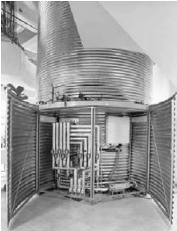
Figuur 52: Buffervat in een passiefwoning
