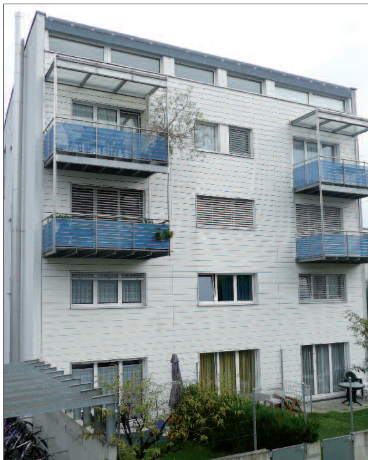
Lames épicéa brossées, traitées industriellement il y a 16 ans avec une peinture couvrante. Aucun entretien n'a été effectué depuis.
