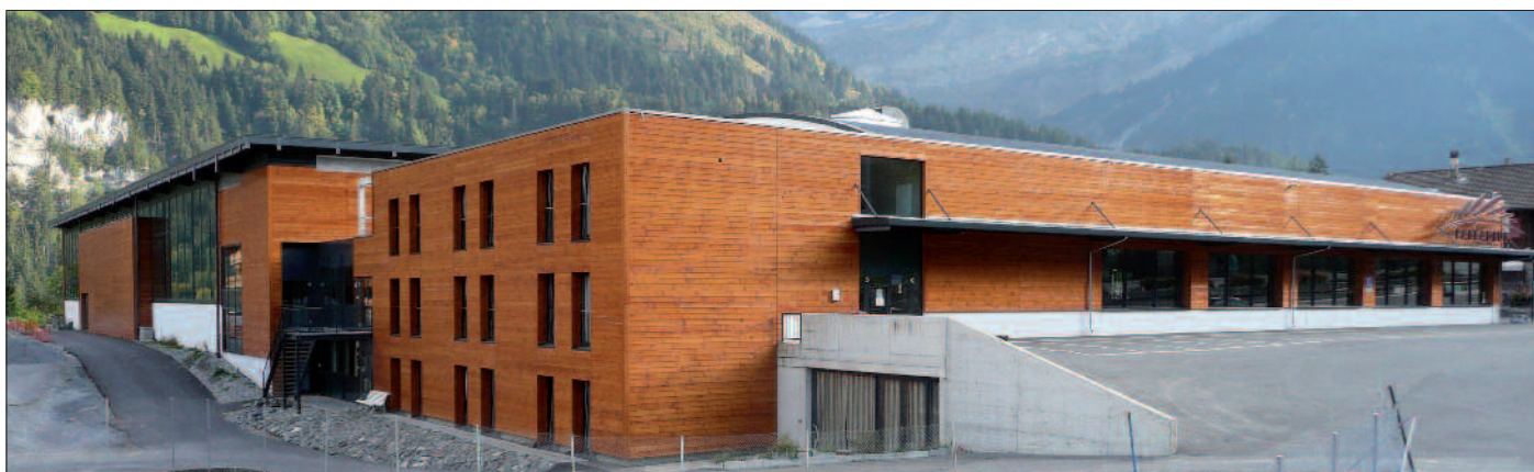
Traitement incolore à l'huile, de lames douglas.
