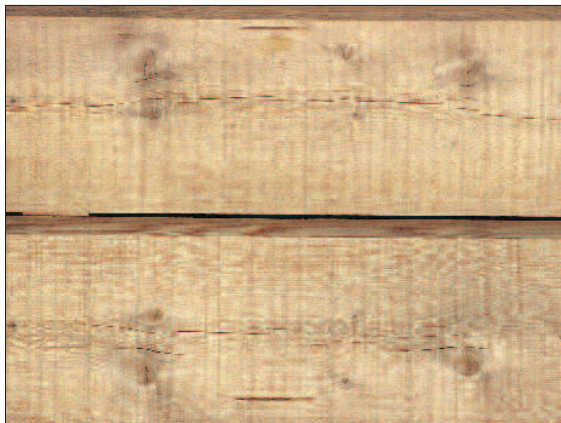
Traitement hydrofuge incolore des lames autoclavées.
