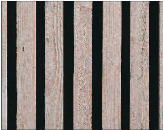
Le traitement hydrofuge incolore permet un grisaillement uniforme.
