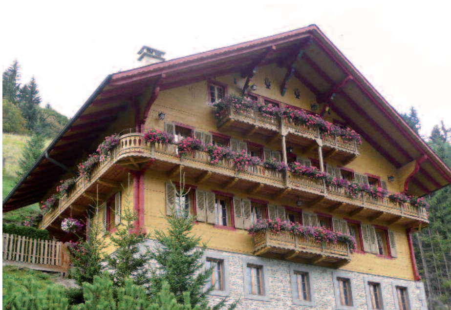
La lasure opaque permet une grande diversité de teintes fortes en laissant apparaître la structure du bois.
