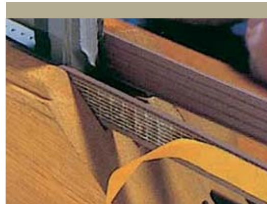
Exemple de pose de joint EPDM.
