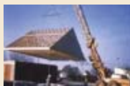
exemple de pré-montage de charpente industrialisée
