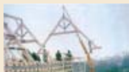
exemple de pré-montage de fermes traditionnelles
