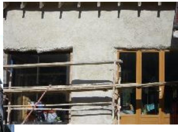
**3 couches d'enduit nécessaire (chaux hydr., aer., sable)**
