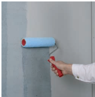
Figure 1 : Appliquer le primaire FERMACELL
