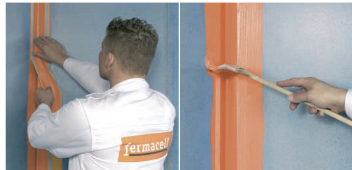
Figure 2 : Presser la bande d'étanchéité FERMACELL dans le lit d'étanchéité encore liquide et, en un 2 ème passage, la recouvrir complètement d'étanchéité liquide
