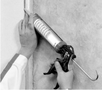
Figure 20 : Guidage de la cartouche de 310 ml le long du chant de la plaque
