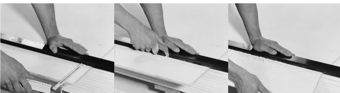
Figure 11 : Détermination de la ligne de rupture
