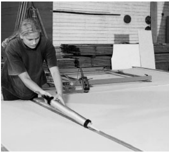
Figure 19 : Application de la colle à joints FERMACELL avec la gaine alu pratique de 580 ml
