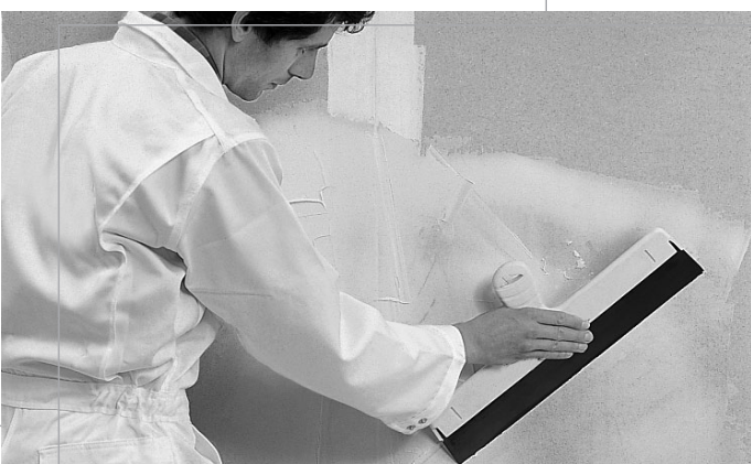
Figure 30 : Application de l'enduit de lissage
