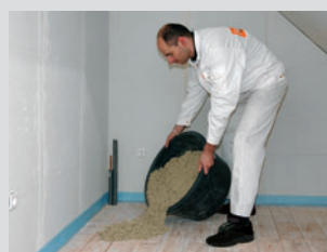
Après le mélange, le mortier d'égalisation a une humidité comparable à de la terre
