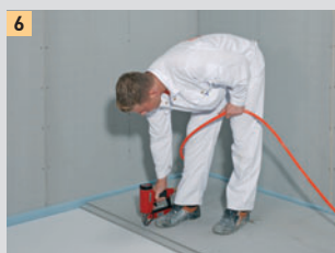
... ou des agrafes divergentes de 22 mm
