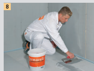
Enduire les fixations et les joints si nécessaire
