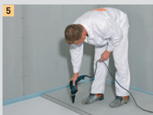
Assembler avec les vis Powerpanel...
