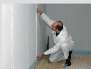
Contrôler la hauteur de ragréage
