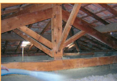
A l'aide d'une cardeuse souffleuse prévue pour la cellulose vous pouvez souffler l'isolant sur le plancher des combles, en prenant soin de vérifier l'étanchéité à l'air. Se conformer au dossier technique du Cstb. (écart aux cheminées et spots 17cm).
